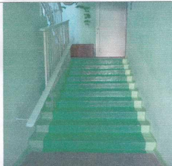
Фото № 18 Лестница внутри здания
