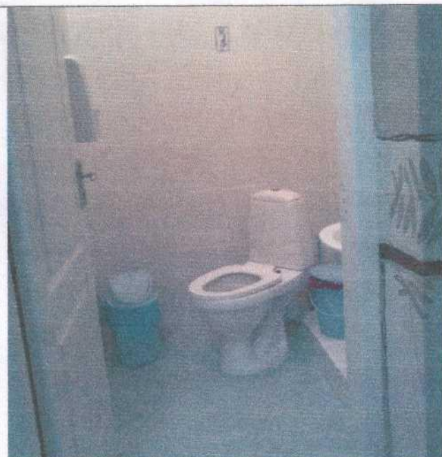
Фото № 23 Туалетная комната
